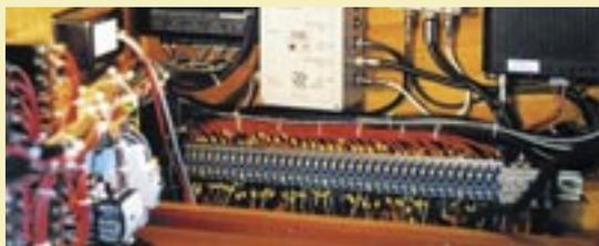
Die Klemmleisten können jederzeit ergänzt werden. Für die Hauptzuleitungen stehen für den –Pol und für den +Pol Klemmen mit einem größeren Querschnitt zwischen 10 mm<sup>2</sup> und 35 mm<sup>2</sup> zur Verfügung. Die Klemmen für den Verbraucheranschluss sind für 4 und 6 mm<sup>2</sup> Kabel ausgelegt. Bei allen einpoligen Klemmleisten sind die Minusklemmen untereinander gebrückt und bilden ein Potential. Somit dienen sie auch als Sammelschiene für die Minusanschlüsse der Verbraucher.
